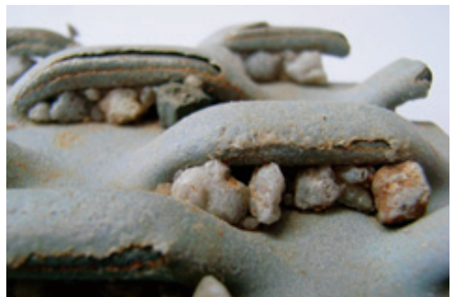
Abb. 2 Beispiel für verstopfte Filterschlitzöffnungen ohne Verockerung
