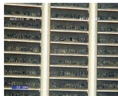
Abb. 4 Mit Glaskugelschüttung und Wickeldrahtfilter ausgebauter Brunnen
