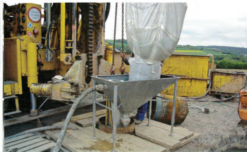
Abb. 6: Einbau von Glaskugeln in Brunnen über Schütttrichter
